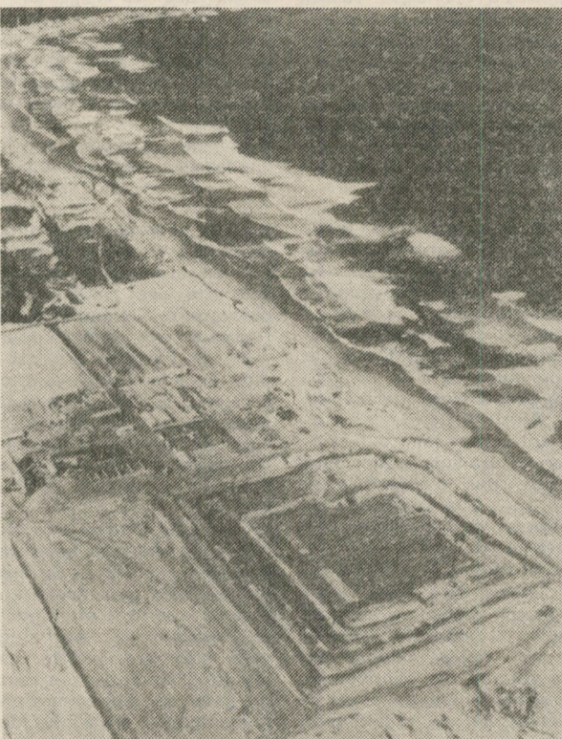
Vue aérienne des travaux en cours de la centrale de Koeberg.
